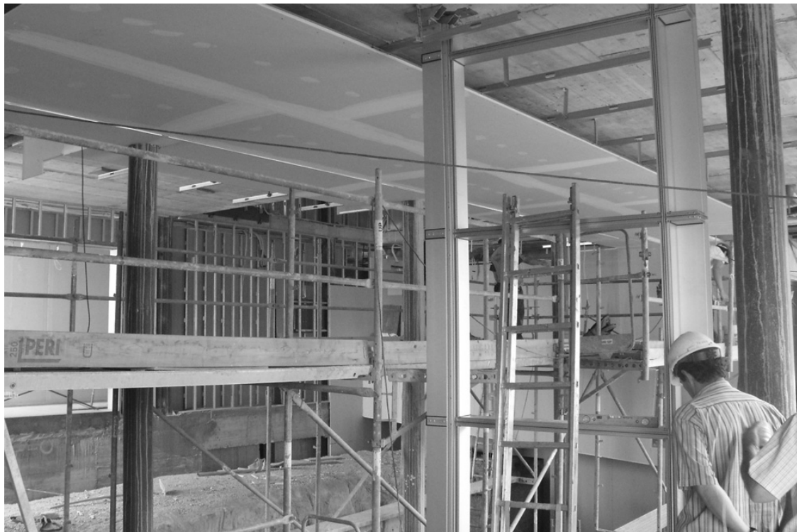
Obras en el edificio de la plaza de las Palomas.
