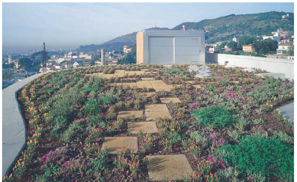
Un ejemplo de una cubierta vegetal instalada en la terraza de un edificio en plena ciudad.
