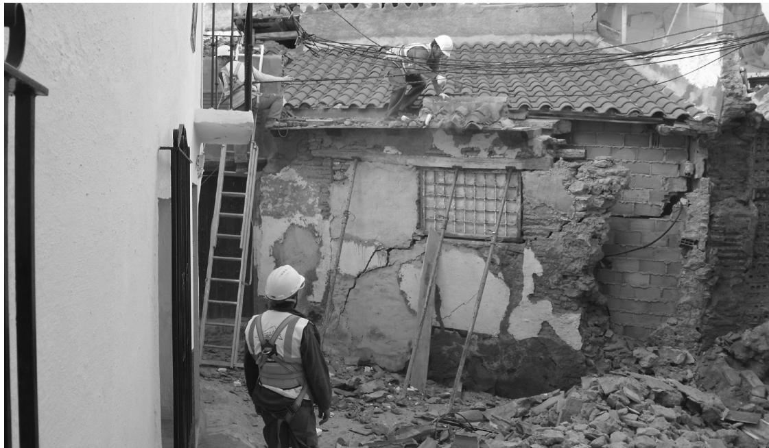
Demolición de la vivienda dañada.
