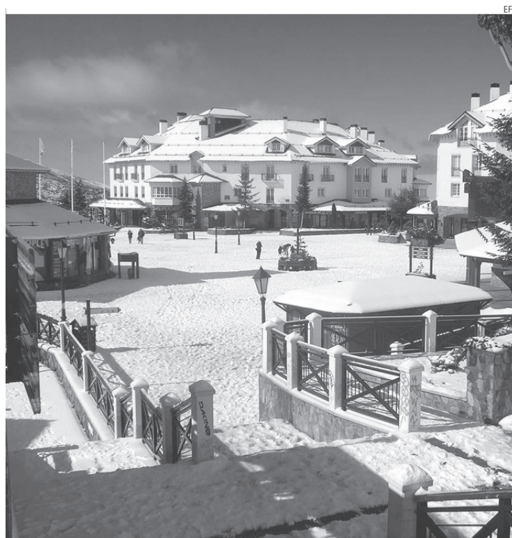
La calidad de las instalaciones es una característica principal de la estación.
