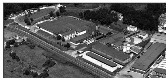
Fábrica en Caldas (Pontevedra).
