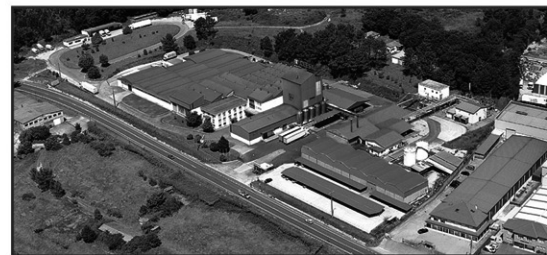
Fábrica en Caldas (Pontevedra).
