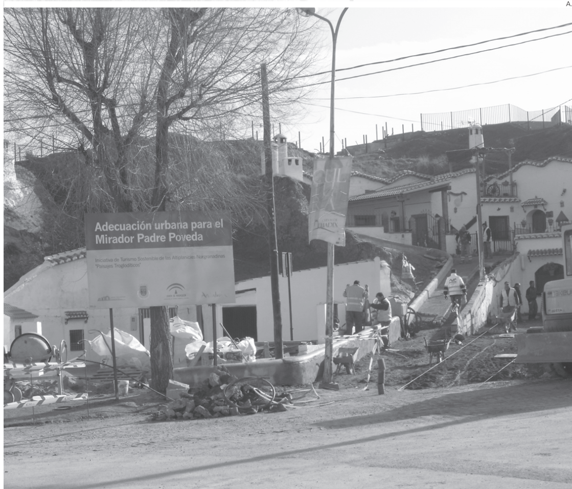
Obras que actualmente se están llevando a cabo en el mirador Padre Poveda.
