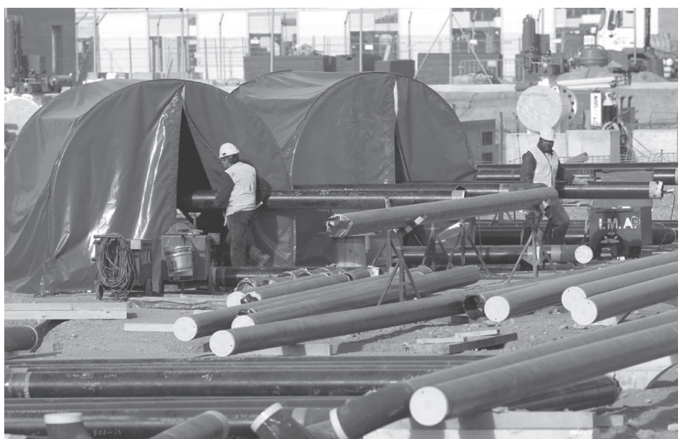
Una vista de las tuberías que han servido para crear un gasoducto que mide 210 kilómetros.
