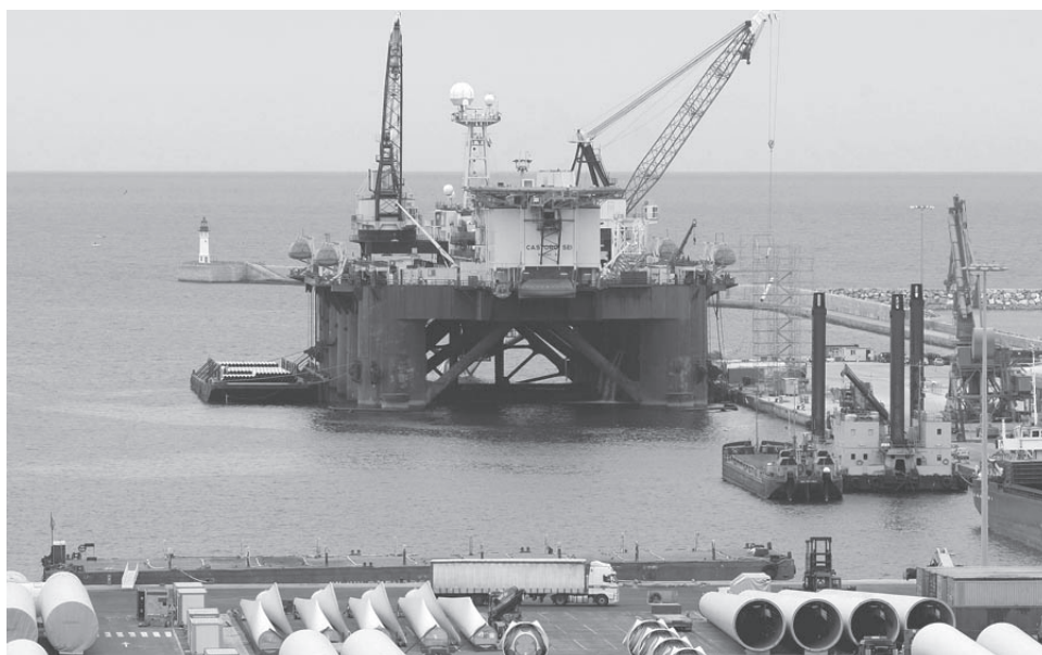
La plataforma instalada en el puerto de Almería para la construcción de este gasoducto.
