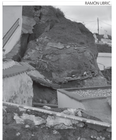
Derrumbe en Graena.
