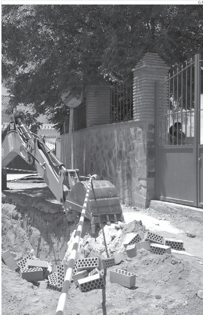
Obras en las Cuatro Veredas.
