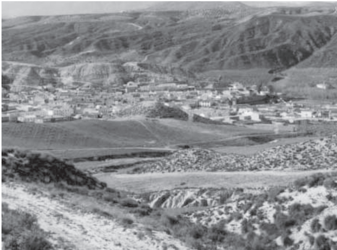
Vista aérea del pequeño municipio de Alamedilla ubicado en los Montes Orientales.
