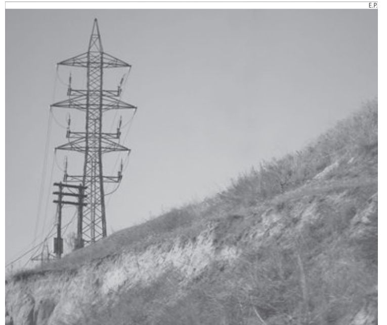
La empresa realiza trabajos preventivos en instalaciones eléctricas.
