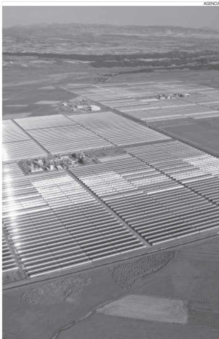
Planta termosolar de la comarca de Guadix.
