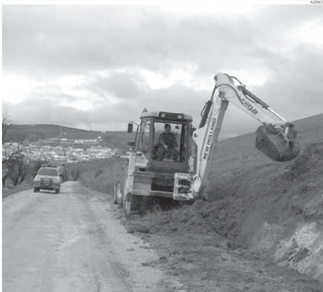
Obras en un camino rural de la provincia.
