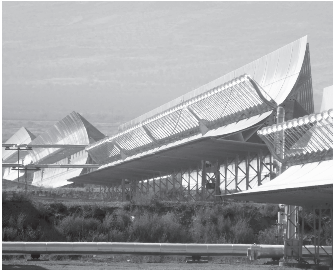
Planta termosolar Andasol.
