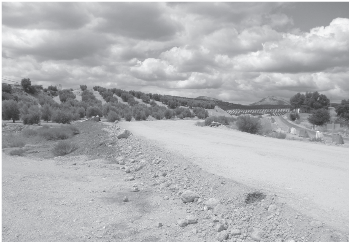
Obras inacabadas de la carretera.
