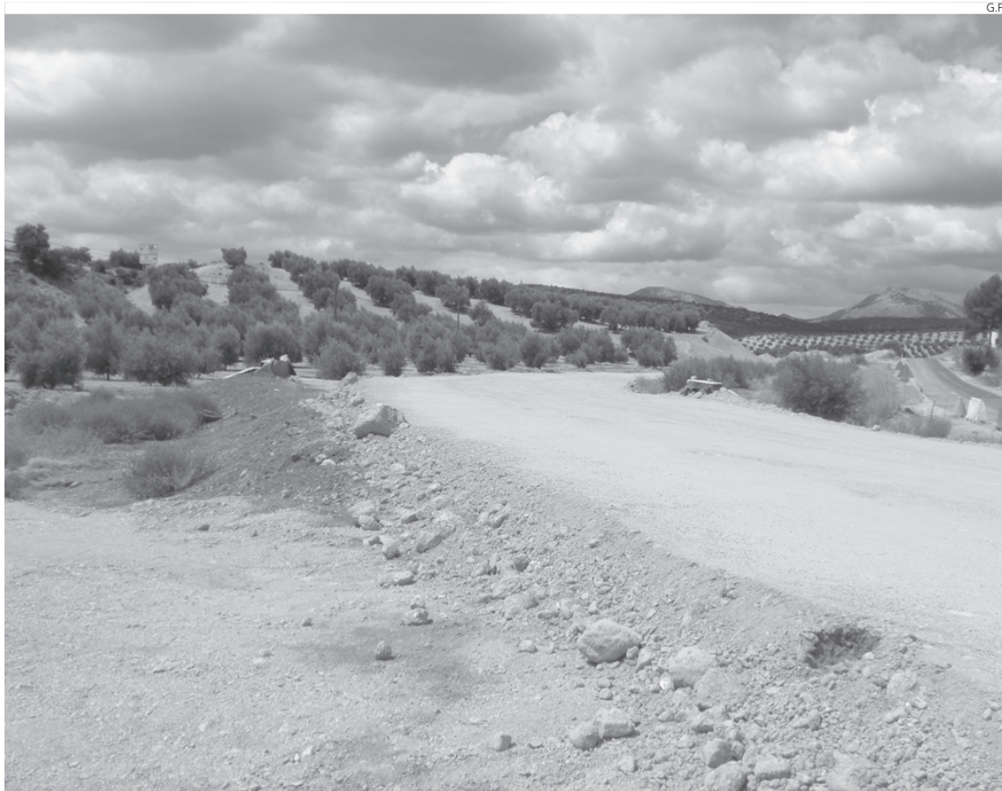
Obras en la carretera A-323.
