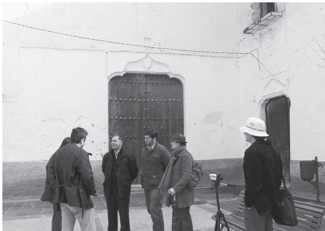
La iglesia de San Francisco requiere una actuación de emergencia desde años atrás.
