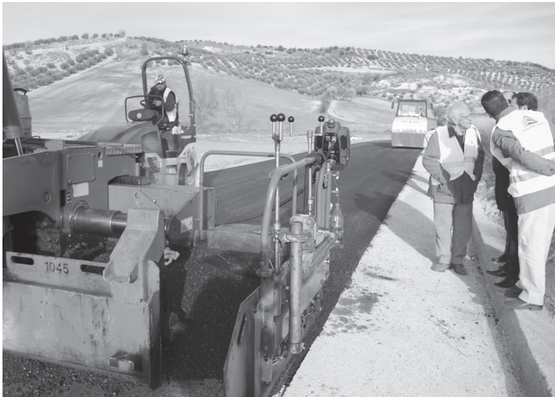
Obras que se están llevando a cabo en esta carretera.
