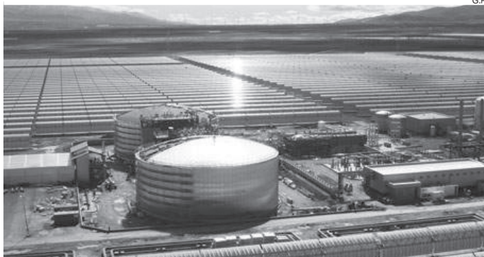
Planta solar Andasol de Aldeire.
