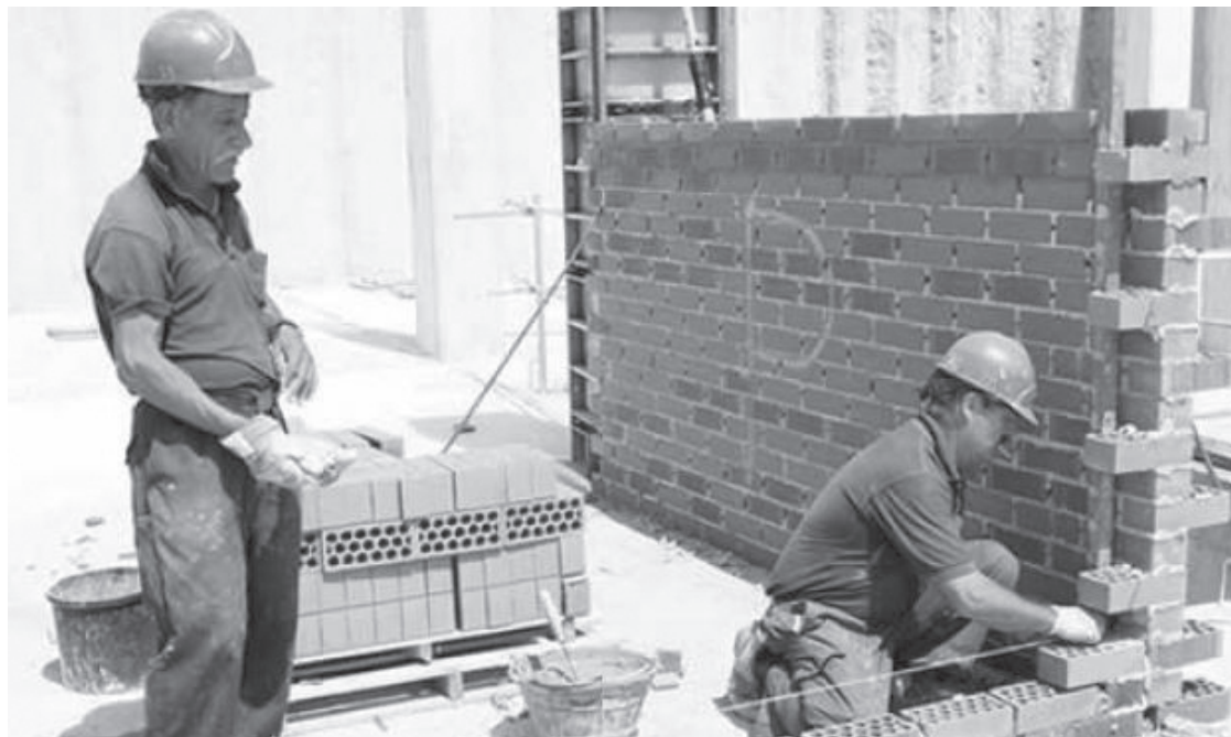
Dos operarios trabajando en una obra.
