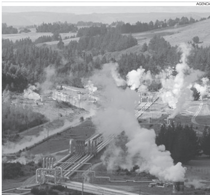
Una planta geotérmica en Nueva Zelanda.
