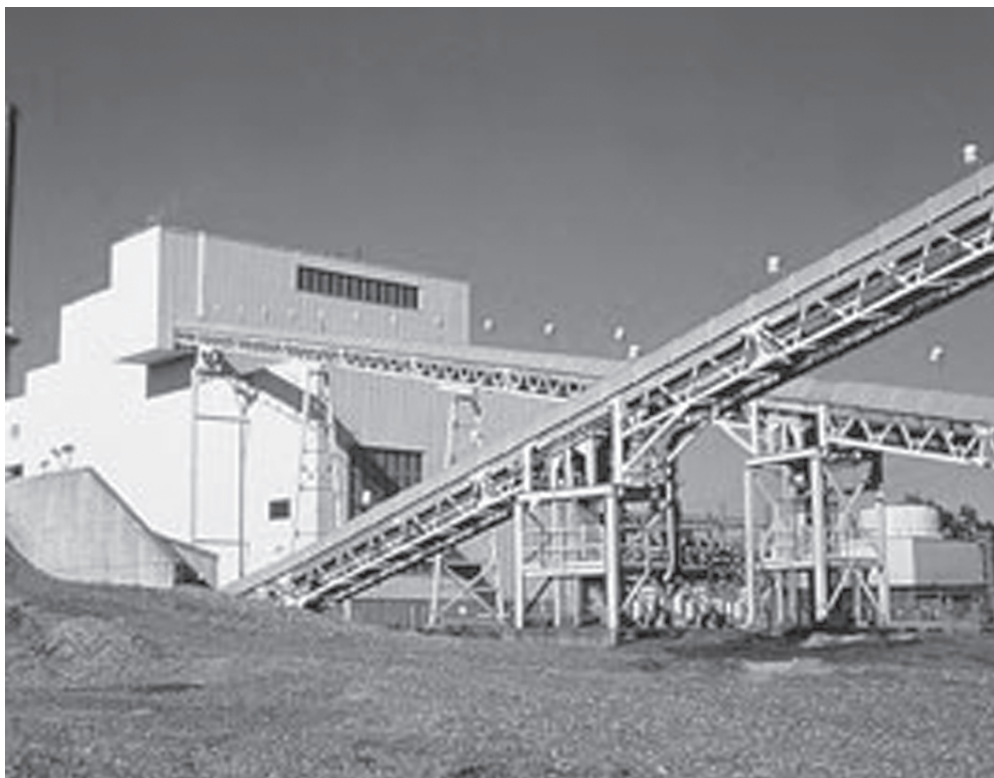
Central de biomasa.
