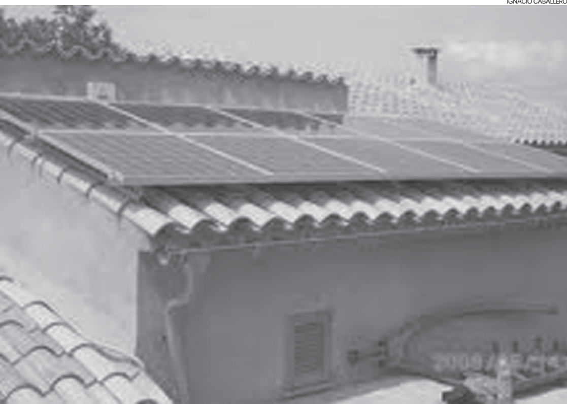
Colectores fotovoltaicos, generadores de electricidad para viviendas.
