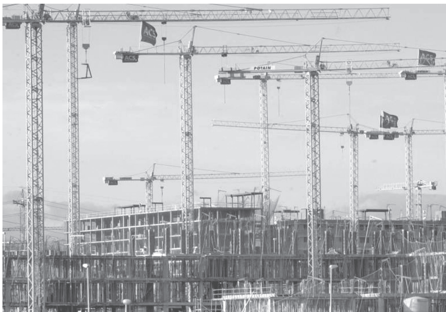
La crisis se ha notado especialmente en Andalucía en el sector de la construcción, pero todavía siguen dominando las grúas en algunas zonas.
