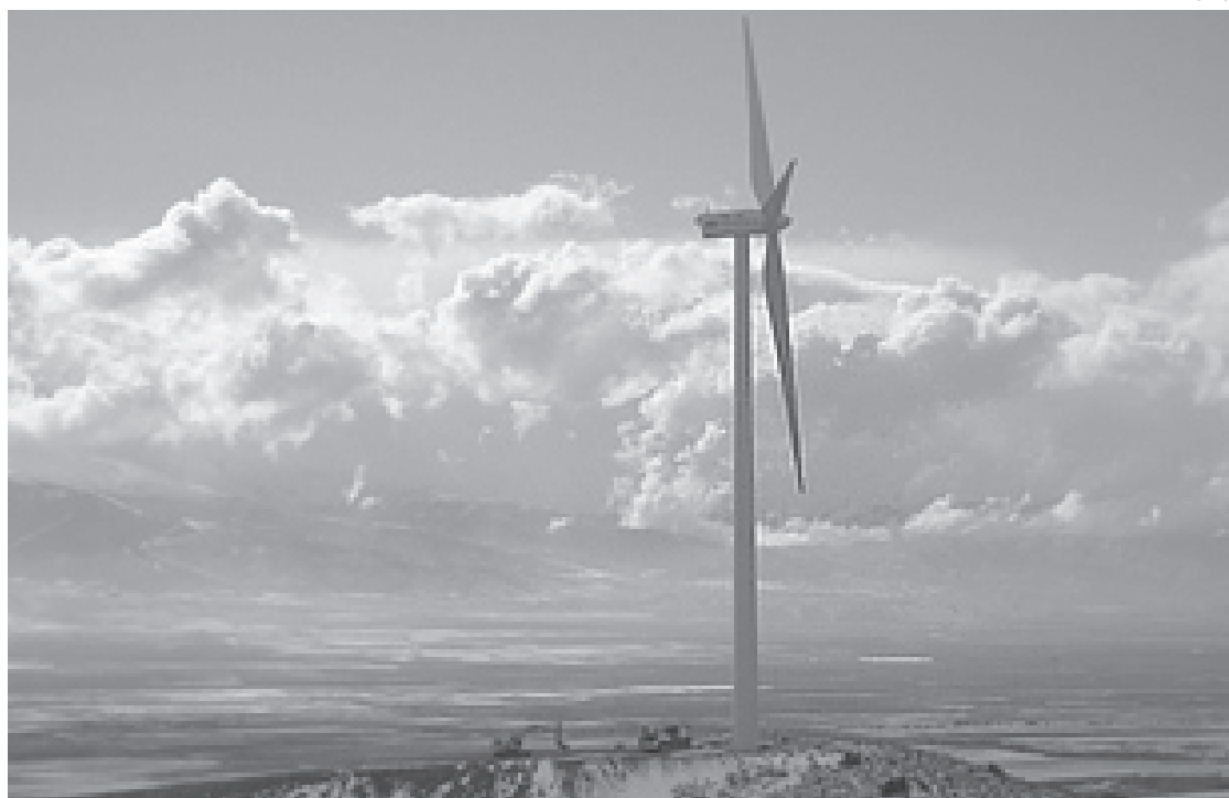
La energía eólica ha crecido en los últimos años en Andalucía considerablemente.
