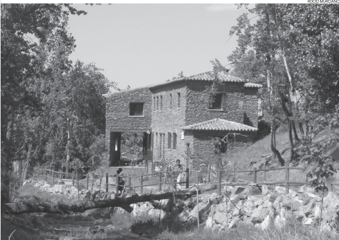
Paisaje rural de pinares y castaños vigilado por los reformados molinos en Lanteira.
