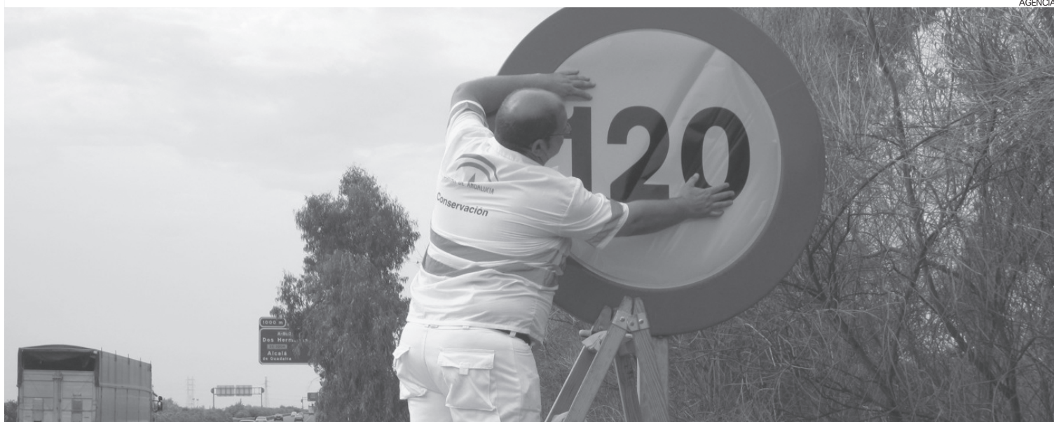
Trabajadores de uno de los centros de conservación cambian una señal de tráfico.
