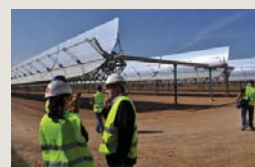
Central termosolar Andasol.
