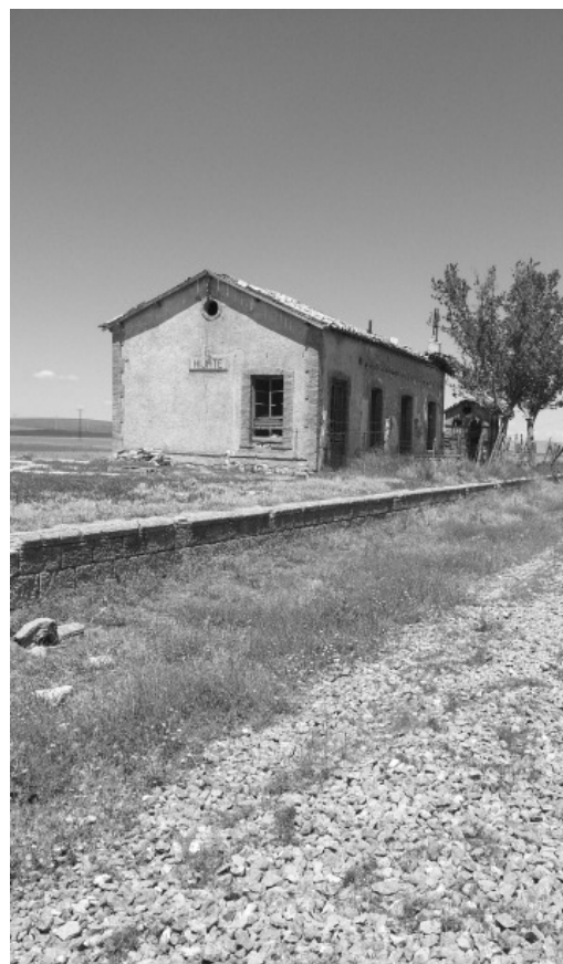
Situación actual de la estación de Caniles.
