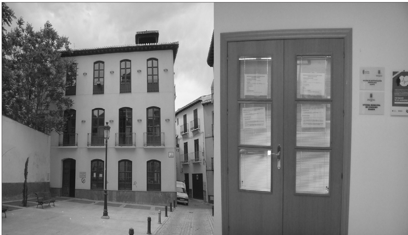
OMIC de Guadix situada en la planta baja de la Biblioteca Municipal José Asenjo Sedano en la Plaza San Francisco
