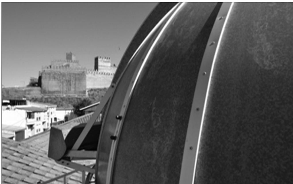
el montaje eléctrico y montó su propio telescopio. El observatorio hecho de aluminio y aislante térmico, mide 3 metros de diámetro.
