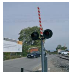
Paso a nivel de Benalúa.
