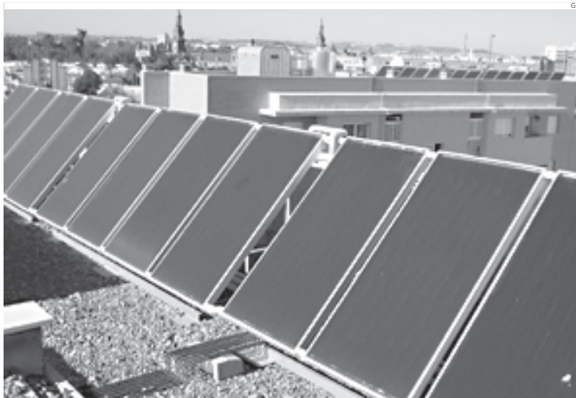
Las obras para el aprovechamiento de fuentes renovables aparece como una de las actuaciones incentivables.
