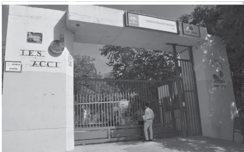
El IES Acci será uno de los centros que mejorará sus instalaciones.
