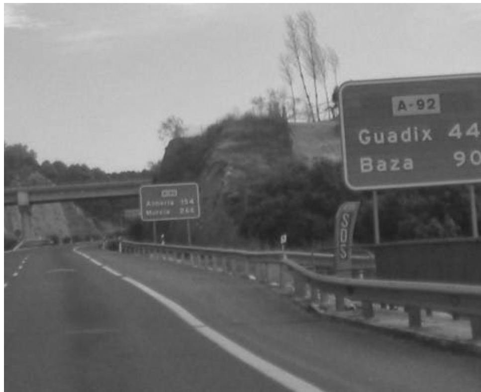
Autovía A-92. AGENCIA
