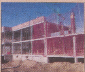
Obras del hospital.
