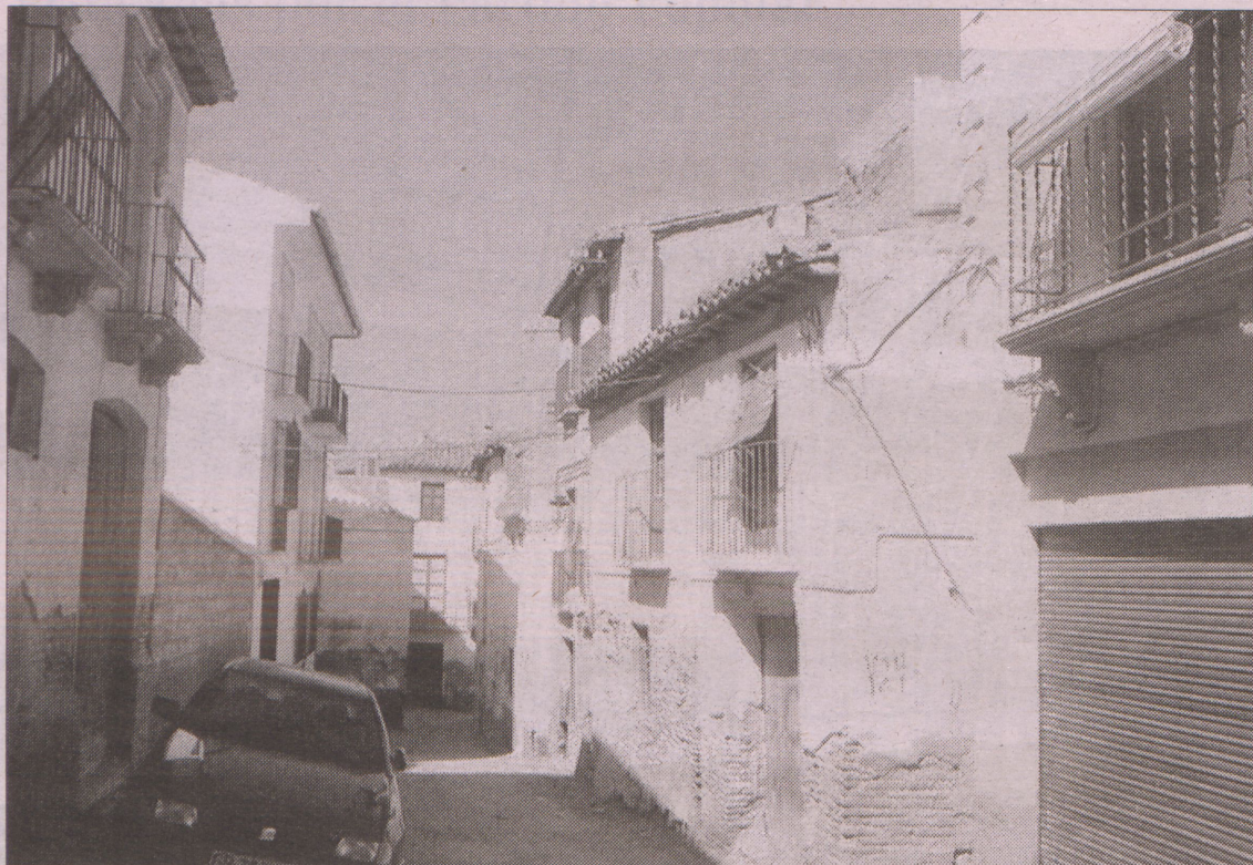
Un programa para rehabilitar viviendas.
