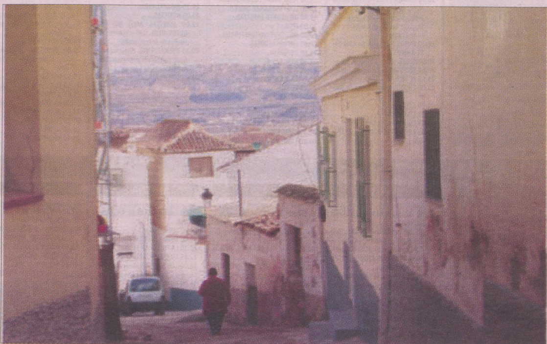
Estas escaleras es el mejor ejemplo del mal estado de la zona.
