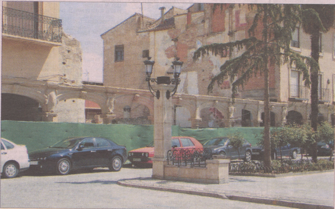
La mella de la Plaza, uno de los principales defectos.
