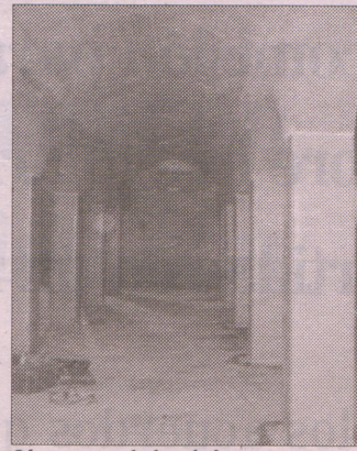
Obras en el depósito.
