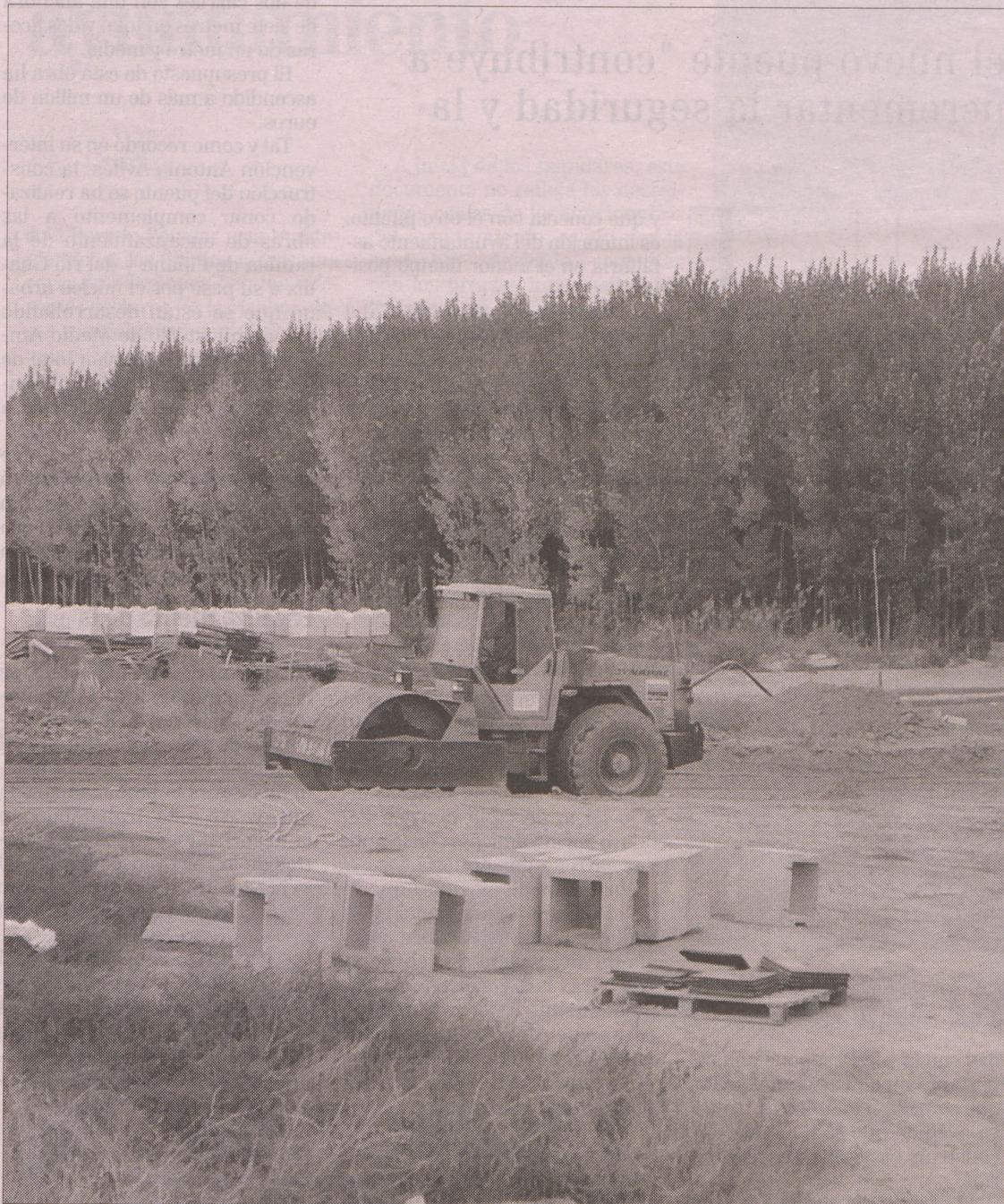
Trabajos de urbanización.
