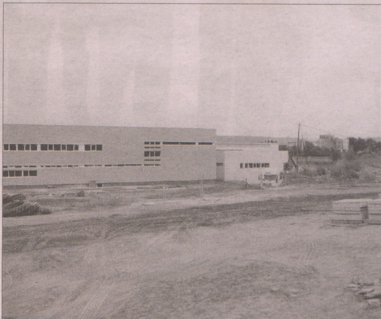
Zona lateral del hospital.
