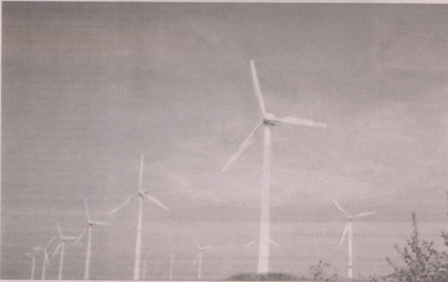
Así quedarán en unos meses la zona de los parques eólicos en el Marquesado.
