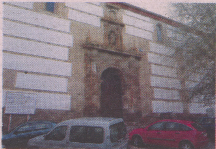
La iglesia de la Magdalena tras su rehabilitación.
