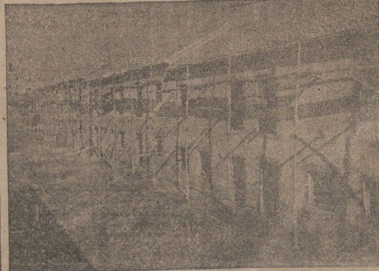
Otra vista de las viviendas que actualmente construye en Granada la Obra Sindical del Hogar (Grupo Bermúdez de Castro). — (Foto ARCHIVO.)
