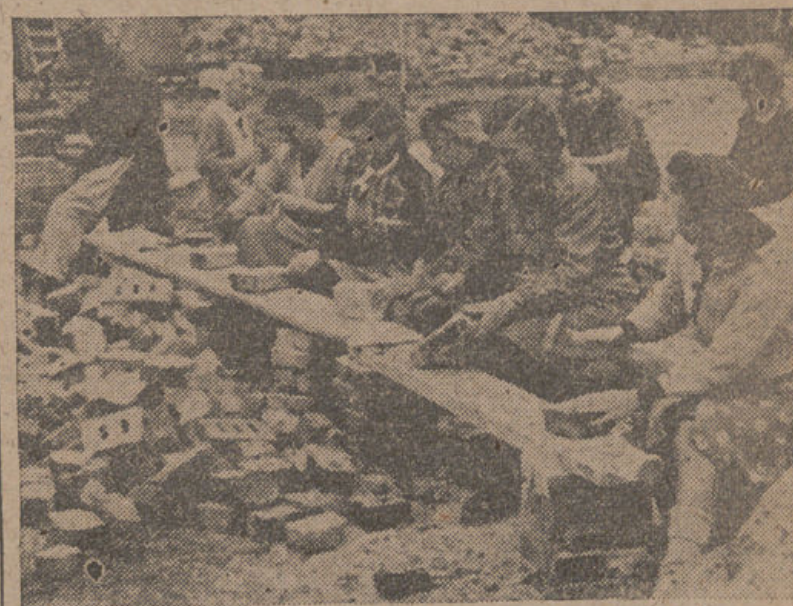
Mujeres alemanas entregadas a la tarea de restaurar los ladrillos de los escombros de Berlín para aprovecharlos en nuevas construcciones. (Foto GIL DEL ESPINAR.)
