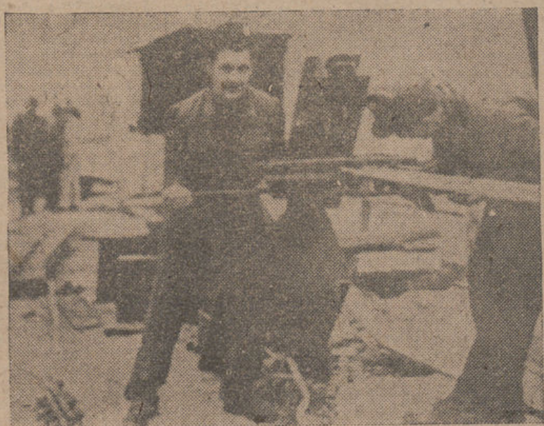
Bajo la vigilancia de los ingenieros militares ingleses, los alemanes de la zona de ocupación británica han comenzado la reconstrucción de sus puentes destruidos durante la guerra. Dos zapadores, uno británico y el otro alemán, trabajando en la reconstrucción del puente Autobahn, sobre el río Weser. — (Foto GIL DEL ESPINAR)
