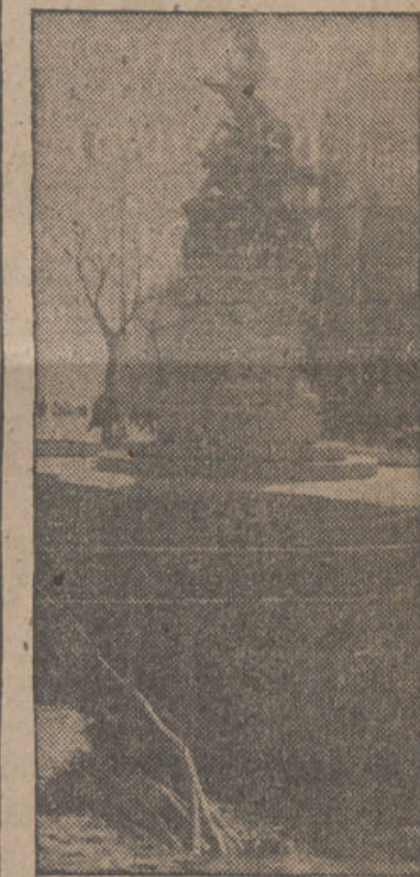
Se ha hundido el pavimento de la parte central de la glorieta de Quevedo, dejando casi en el aire una estatua que hay en dicho lugar. Un aspecto del hundimiento, que revistió carácter de gravedad, ya que el agua de las cañerías rotas inundó una galería del "Metro".
