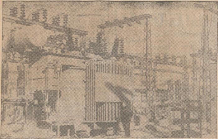
Uno de los aparatos transformadores de la subestación eléctrica de Avila, que recibirá y transformará la corriente producida por los saltos del Alberche.
