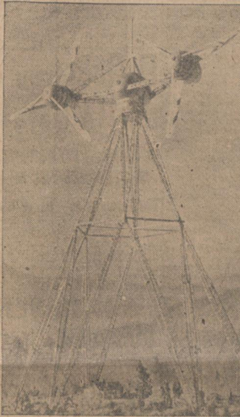
El fantástico modelo de molino de viento gigante que aparece en el grabado, demuestra bien a las claras la fe que se tiene puesta en Estados Unidos en la fuerza del viento para generar energía eléctrica. La construcción tiene apenas veinticinco metros, instaladas en un puente que remata una torre de cincuenta metros de altura, y se espera que produzca 6.500 kilovatios bajo la fuerza de un viento de cuarenta y cinco kilómetros por hora.
