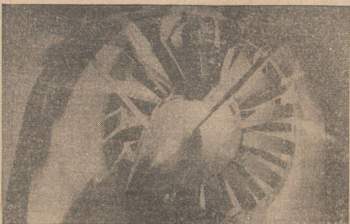
He aquí el ventilador de dieciséis pies, capaz de producir velocidades de aire de más de 2.400 kilómetros por hora en los túneles aerodinámicos para velocidades supersónicas, donde se comprueban los últimos modelos de aviones-cohete.—(Foto CIFRA.)
