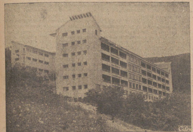
Nuevo dispensario antituberculoso "Generalísimo Franco", dotado de las instalaciones más modernas, inaugurado recientemente en Bilbao.—(Foto Espinar.)
