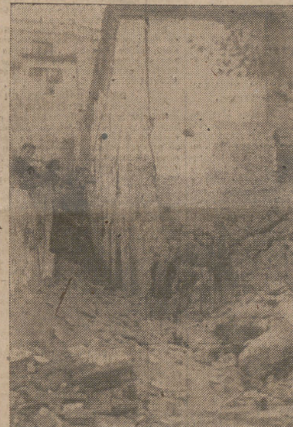
Aspecto que ofrece la calle del Santísimo, cubierta de escombros por el derrumbamiento de dos tapias a consecuencia del temporal de lluvias. En la foto queda apreciarse la grieta que simultáneamente se abrió en la casa número 4 y que amenaza con el desmoronamiento total de la fachada. (Foto LEONARDO.)
