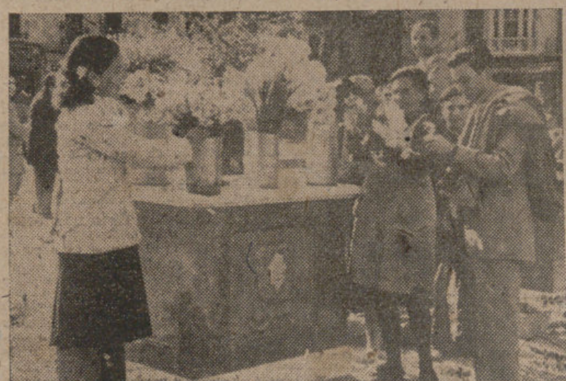
En la plaza de Bibarrambla están siendo instalados estos días nuevos puestos para la venta de flores, que serán como pletados con un gran quitasol, según el proyecto del Municipio. La foto muestra uno de estos pequeños quioscos, que tanto alegrarán la perspectiva de la histórica plaza. — (Foto LEONARDO.)
