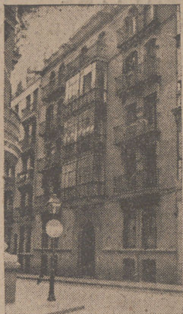
Durante la gran tormenta desencadenada hace unos días sobre Madrid, fue alcanzada por un rayo la casa número 21 de la calle de Churrucá. Afortunadamente la chispa se limitó a quemar la instalación eléctrica del inmueble. (Foto GIL DEL PEÑAR)
