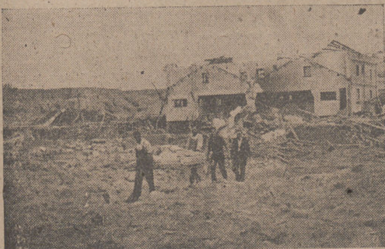
Una polvorita estalló en las inmediaciones de Alcala de Henares en la noche del pasado sábado. Obreros de una fábrica de cerámica proceden a evacuar algunos escombros de la misma, entre los escombros de la nave destruida.
